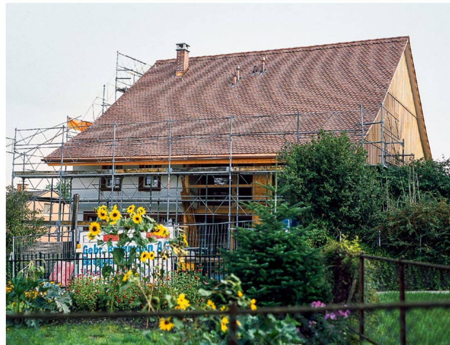
Die Klosterstrasse 1 wird aufwendig renoviert und einer erweiterten Nutzung zugeführt, bei der die ehemalige Struktur des Gebäudes gut sichtbar bleibt. Das Projekt wurde in enger Zusammenarbeit mit der SBK verfeinert und optimiert. Der gegenüberliegende Garten ist Teil des Schutzzumfangs der Liegenschaft und bleibt langfristig erhalten.
