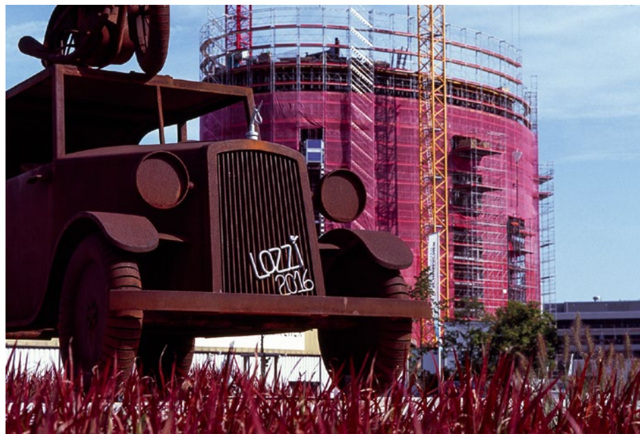
Yvan «Lozzi» Pestalozzi schuf 2016 an der Hochbordstrasse zwei Skulpturen für die Verkehrskreisel. Im Hintergrund dominiert die Baustelle des Jabe Towers das Bild, der monatlich ein Geschoss höher wird.
