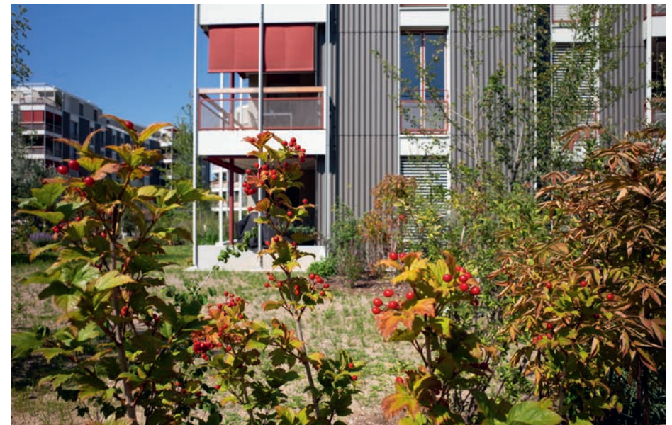
Die vielfältige Umgebungsgestaltung der letztes Jahr neu bezogenen Überbauung Lerchenfeld an der Kirchbachstrasse zeigt, welche Qualität erreicht werden kann mit einer vielfältigen und biodiversen Gestaltung des Freiraums.
