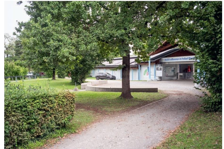
Beim Projekt Hallenbad/Freibad stand die Stadt vor der Frage, wie sich Bauinteressen und Baumschutz verbinden lassen. Es brauchte ein Umdenken: Nicht der Baum stört den Bau, sondern der Bau soll dem Baum Platz lassen.
