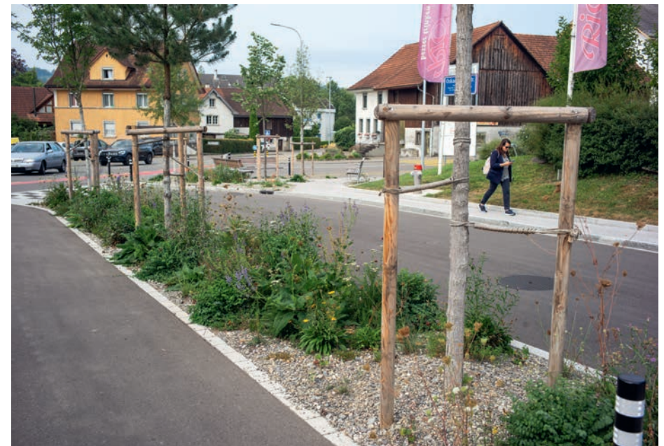
Die Oskar-Bider-Strasse ist ein gutes Beispiel, wie der öffentliche Raum in der Stadt qualitativ neu gedacht wird. Es hat nun mehr und vielfältigere Baumarten, die auf das städtische Klima und seine zukünftige Entwicklung abgestimmt sind. Im Untergrund ist Material eingebaut, das Wasser zurückhält. Wiesenblumen fördern in den Baumscheiben die Biodiversität.
