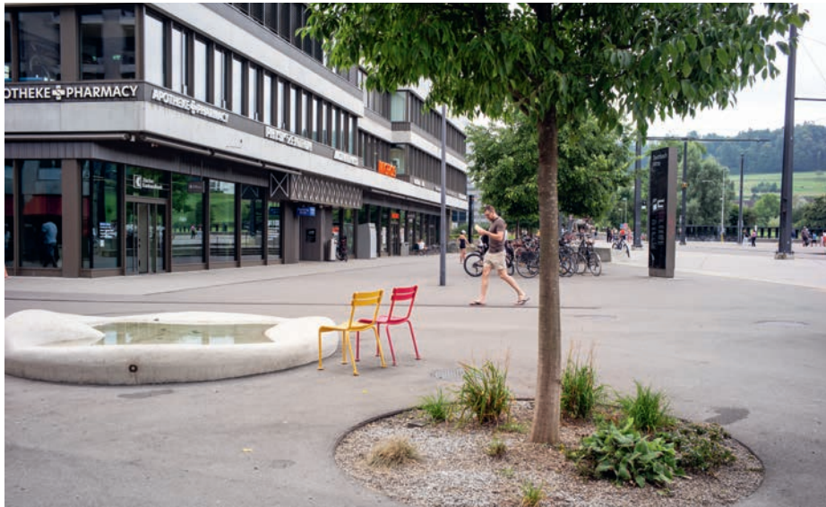
Die Umgebung der Überbauung am Bahnhof Stettbach als Resultat aus einem Wettbewerbsverfahren galt noch vor wenigen Jahren als besonders gut gestaltet. Heute wirkt sie mit ihrem hohen Grad an Versiegelung bereits aus der Zeit gefallen.
